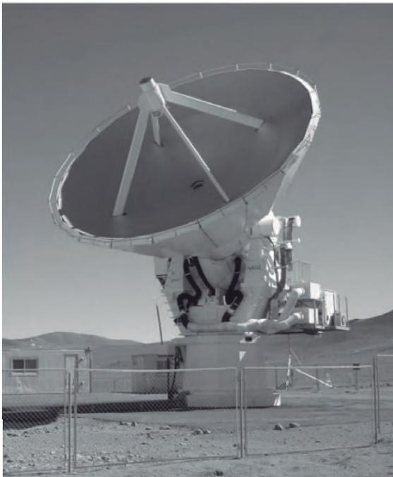
**Figura 5:** Telescopio nacional Japonés ASTE (Atacama Submillimeter Telescope Experiment) de 10 m de diámetro, localizado a 4860 m en Pampa La Bola, desierto de Atacama, Chile, donde se emplazó la cámara AzTEC en los años 2007 y 2008.
