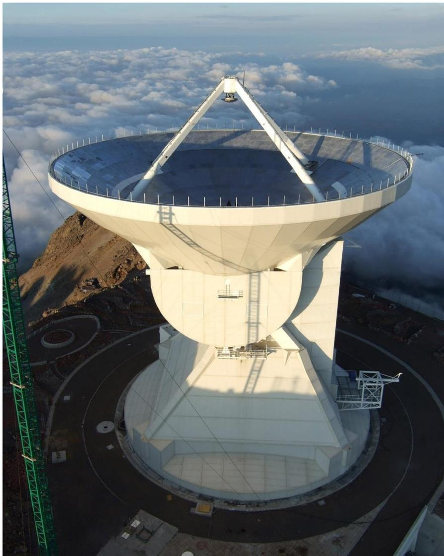
Figura 1 El Gran Telescopio Milimétrico Alfonso Serrano ubicado al Volcán Sierra Negra, Puebla a 4600 metros de altura. Los 32-m de diámetro de la antena de 50-m están dentro de la estructura del tetrápodo. Las primeras observaciones científicas se seguirán realizando con un diámetro de 32-m.
