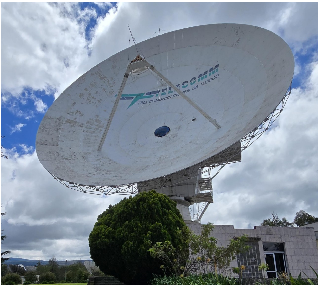
Fig. 1: TUL-1 es una antena orientable de 32 m de diámetro que se encuentra en conversión a radiotelescopio.
