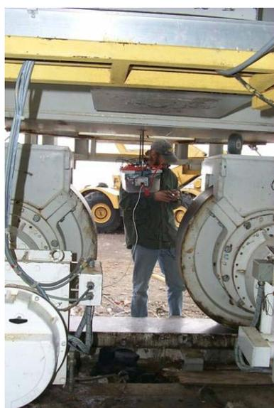
*La instalación y alineación del sistema de rodamiento azimuthal.*
