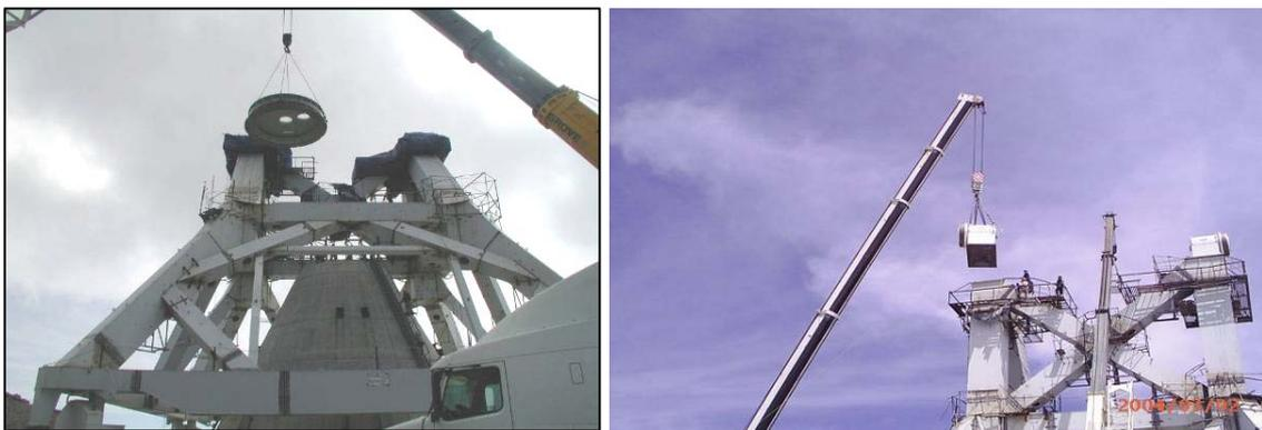
*El montaje del balero azimutal y de los ejes de elevación.*
