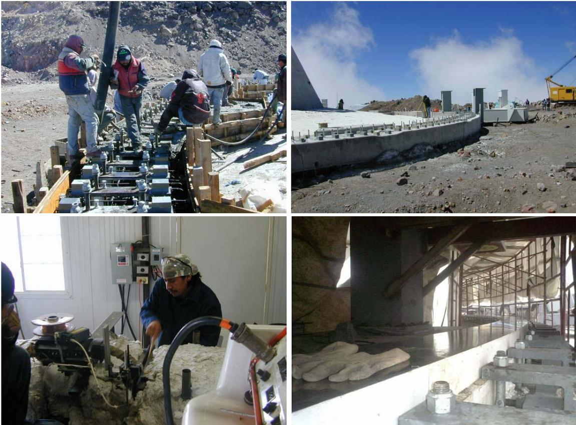
*Arriba, a la izquierda, el proceso de construcción de los durmientes de la pista de rodamiento. A la derecha, el sistema de soporte terminado. Abajo, a la izquierda, el proceso de soldadura del riel. A la derecha, la pista terminada.*
