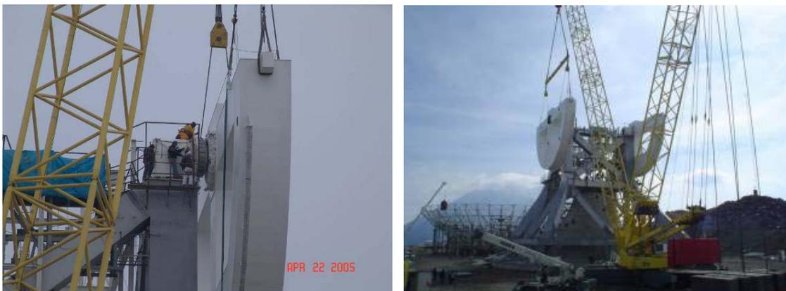
*El montaje de los balastros o contrapesos de la antena.*
